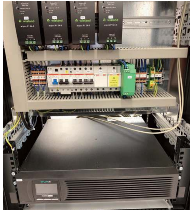
Bild 2 | Die Integration der Stromversorgung inklusive USV gehört zum Standard.
